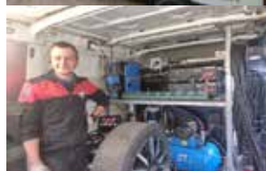
Mezzo da lavoro alimentato da impianto fotovoltaico
