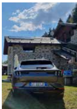
Abitazione con impianto da 5 kW e 220 V
